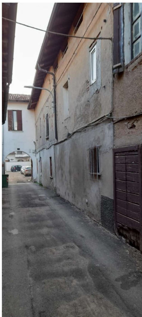
FACCIATA SU VICOLO SCHIERA
