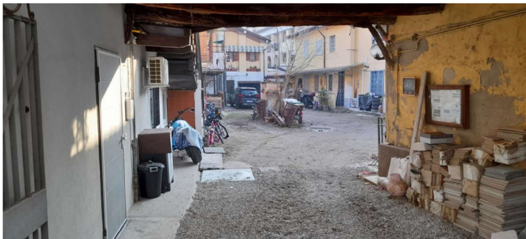
INGRESSO CORTILE COMUNE
