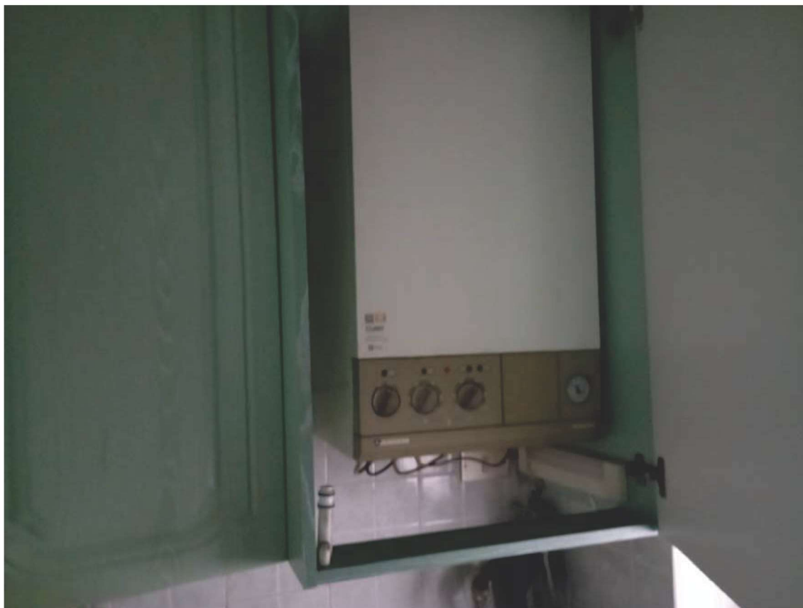
F18 DETTAGLIO – CALDAIETTA MURALE RISC./ACS CORPO A
